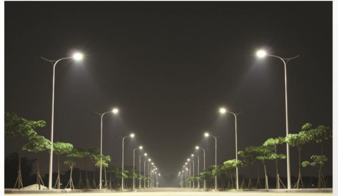
Ledli Sokak Aydınlatması ( 2015 )
